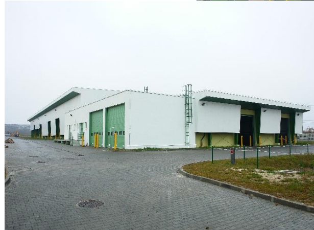
Zakład Przetwarzania Odpadów Komunalnych w Srebrzyszczu (Chełm)
